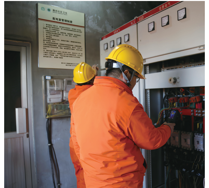
△ “电力啄木鸟”青年志愿服务队走进社区，打通了“客户—社区—营业所”服务渠道。
