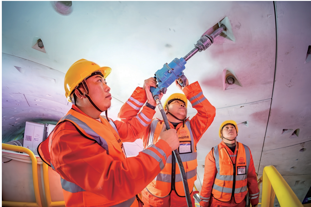
◁ 在中铁十四局京唐城际铁路运潮减河隧道内，施工人员在拼装管片（2024 年 2 月 4 日摄）。新华社发（中铁十四局供图）
