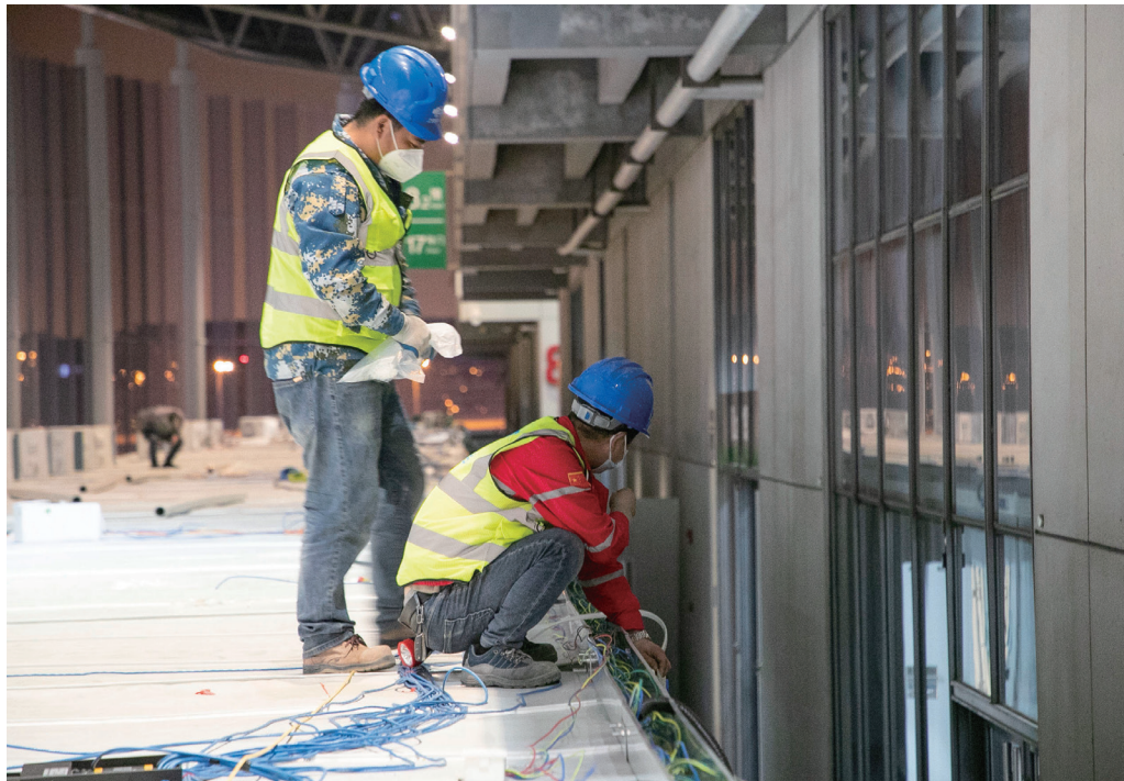
◀ 施工作业现场
