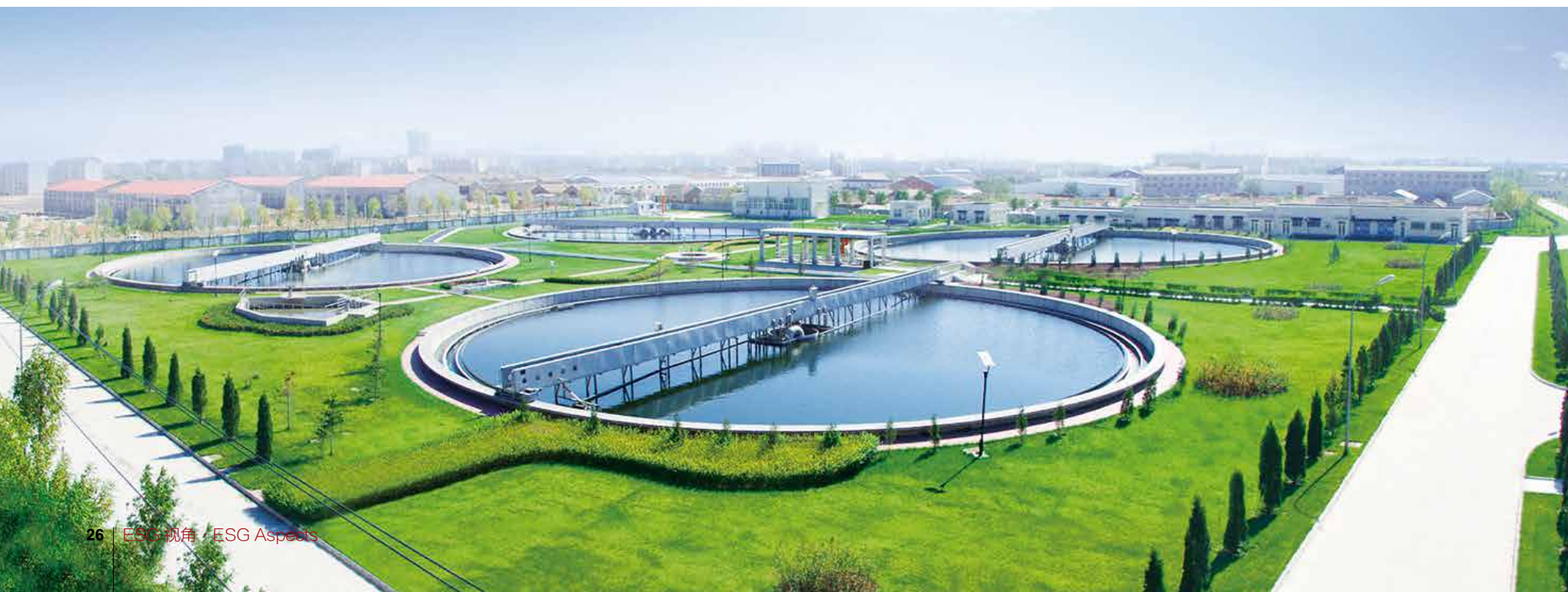
▼ 济南污水处理项目
