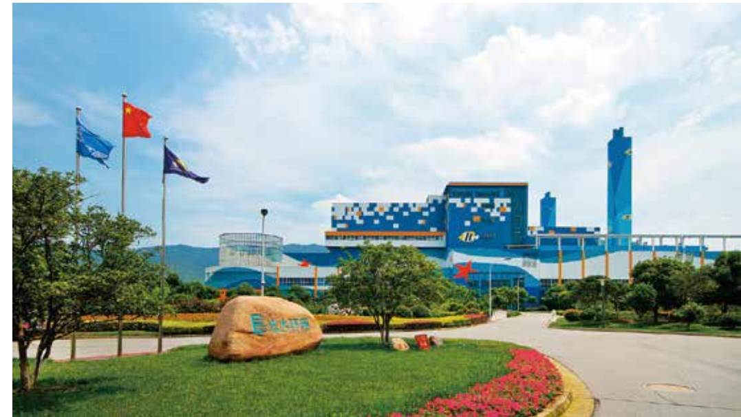
苏州垃圾发电项目 ▲
